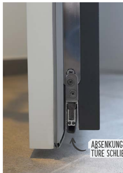
Die automatisch ausfahrende Absenkung (optional) schützt zusätzlich vor Zugluft und Lärm
